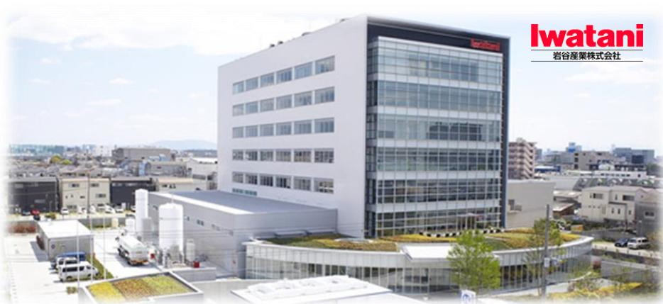
岩谷産業 中央研究所では、BEMS（ビル・エネルギー・マネジメント・システム）を導入し、所内で使用するエネルギーの「見える化」を行っています。また、使用するエネルギーは水素、LPGガス、太陽光、電気という4つの供給源を組み合わせ、研究所全体で岩谷産業が提案するエネルギーのベストミックスを具現化しています。なお、実験で使用した水素は回収して燃料電池により発電を行い、所内で再利用しています。
